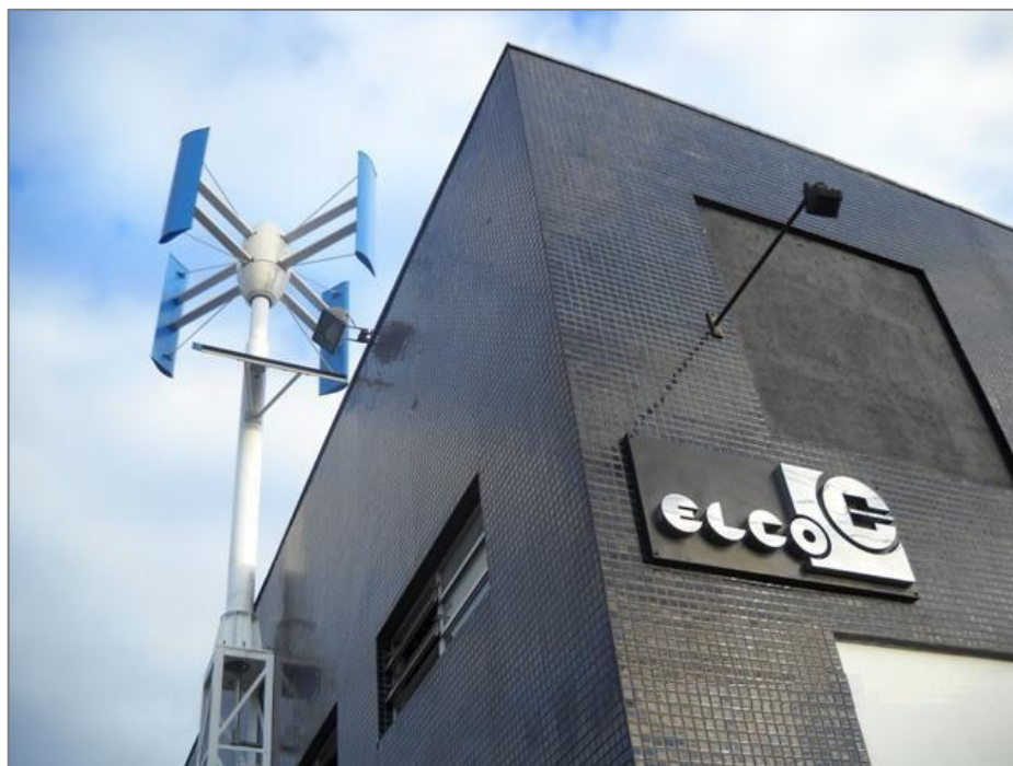
Figura 18 - Fachada da empresa ELCO.
