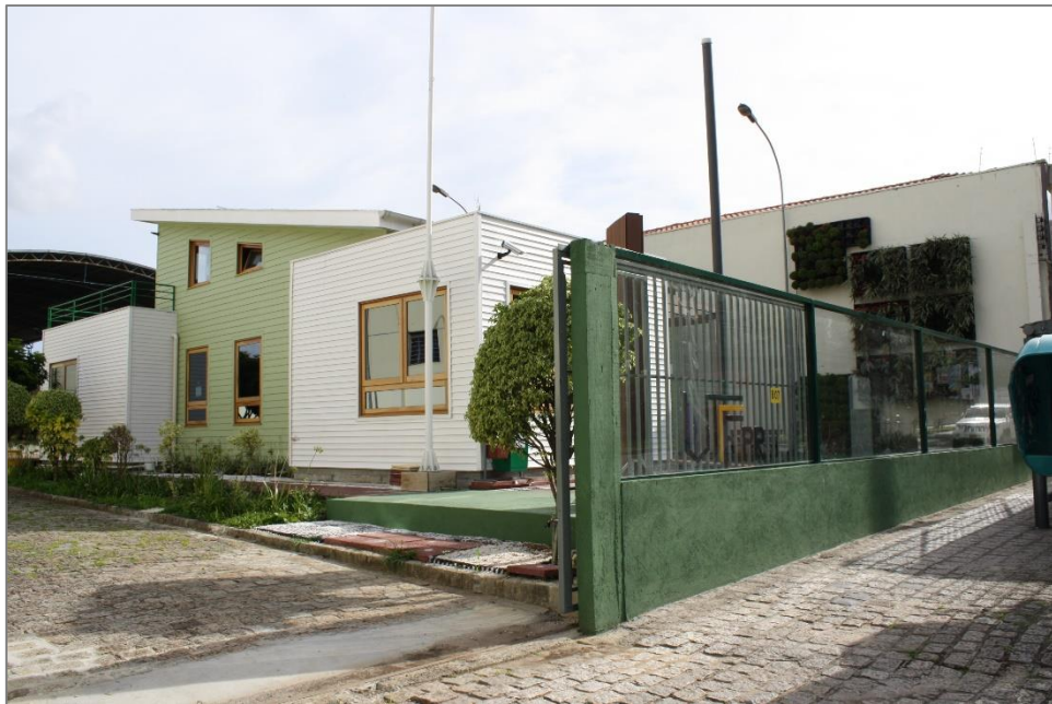
Figura 14 - Fachada do EV.
