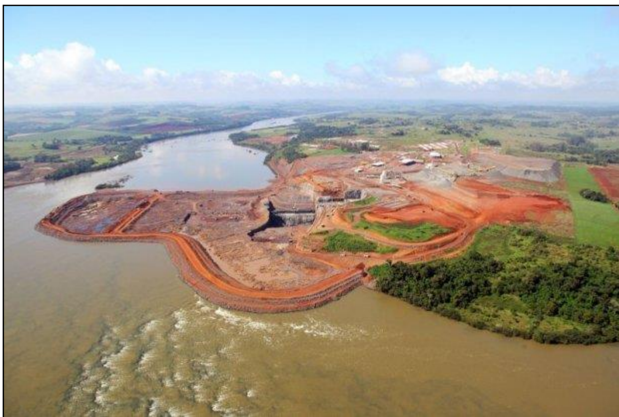
Figura 12– Obras da UHE Baixo Iguaçu ( http://usinabaixoiguacu.blogspot.com.br/ ).
