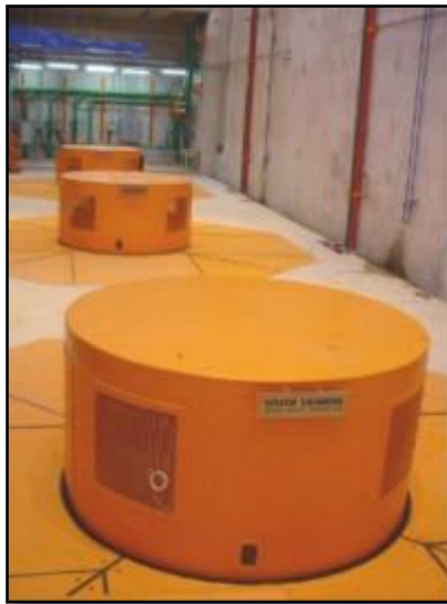
Figura 7– Turbinas tipo Francis, eixo vertical ( http://www.uhesantaclara.com.br/index.asp ).
