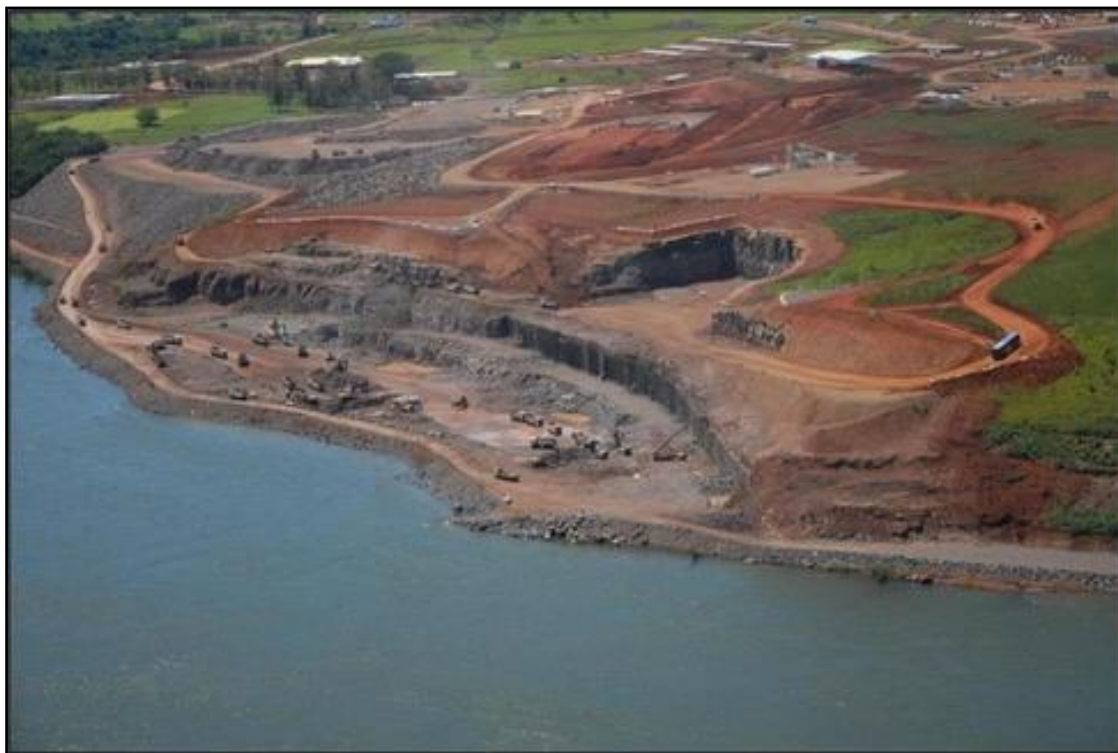
Figura 13 - Obras da UHE Baixo Iguaçu ( http://usinabaixoiguacu.blogspot.com.br/ ).
