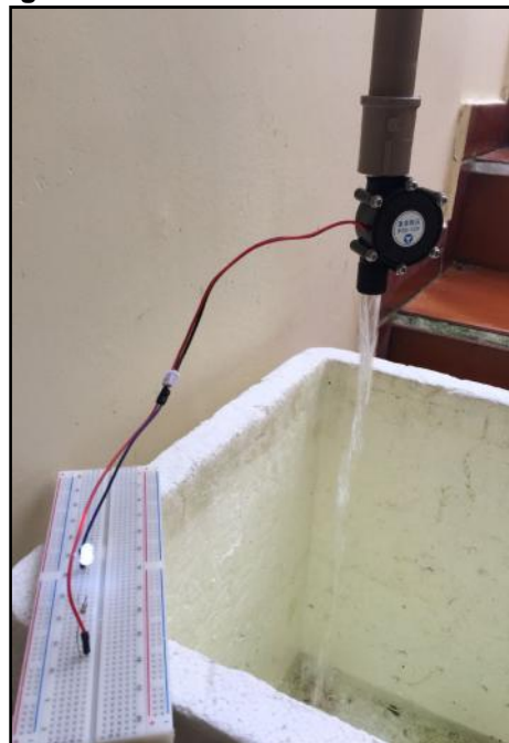
Figura 43. Gerador em funcionamento.
