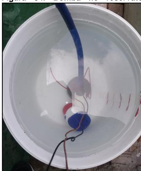
Figura 34. Bomba no reservatório.
