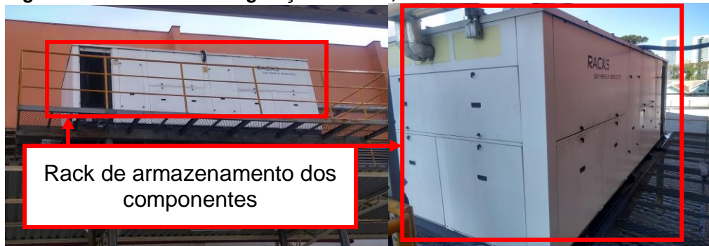
Figura 35 - Sistema de refrigeração cascata, CO 2 e R134a.
