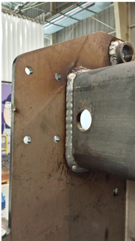
Fotografia 8. Cordão de solda realizado na linha antiga.
