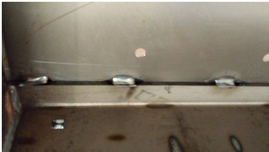
Fotografia 6. Cordão de solda realizado na linha antiga.
