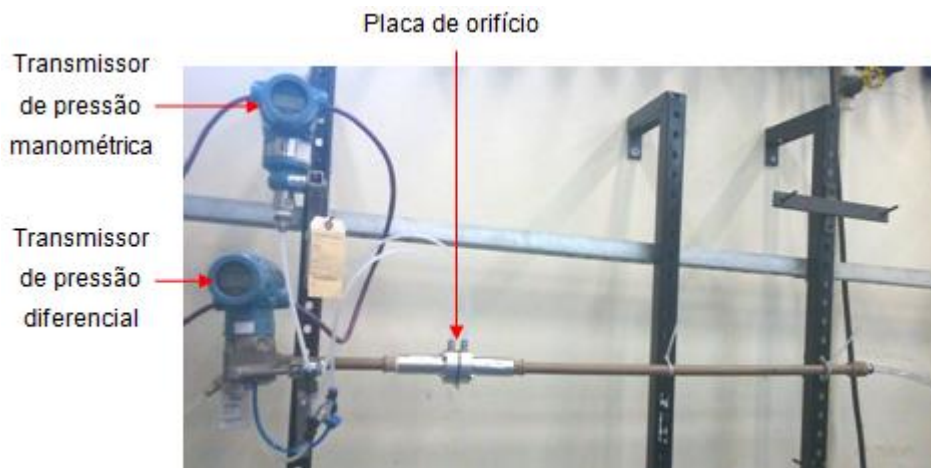
Figura 16 - Sistema de medição de vazão de ar.
