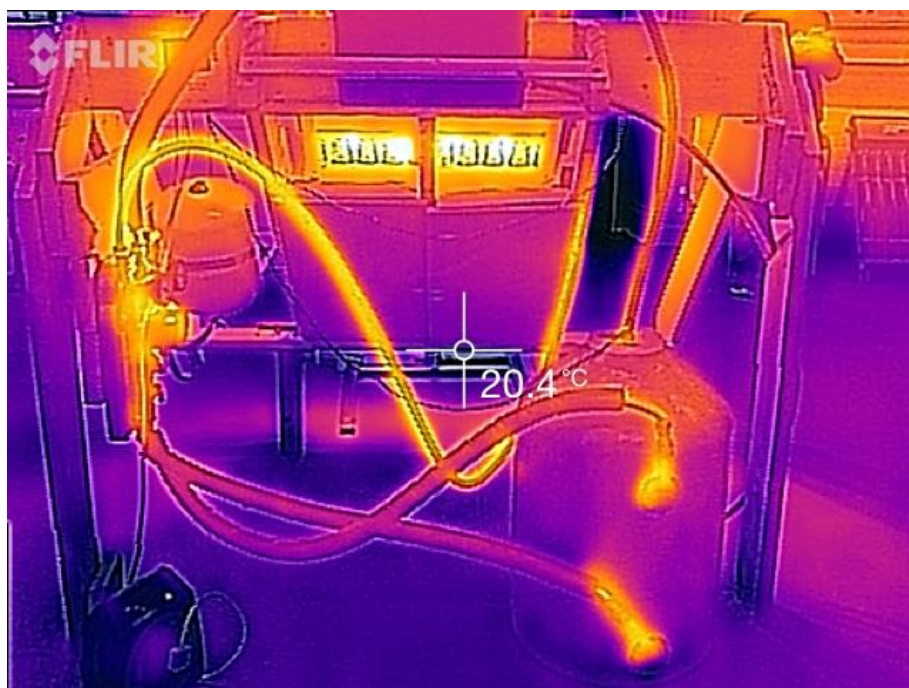
Figura 55 Imagem térmica posterior da estrutura
