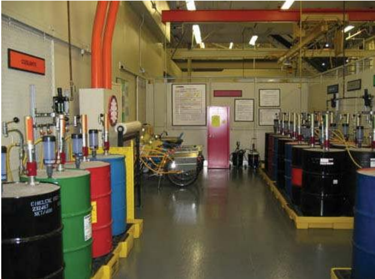
Figura 6: Armazenamento de Lubrificantes
