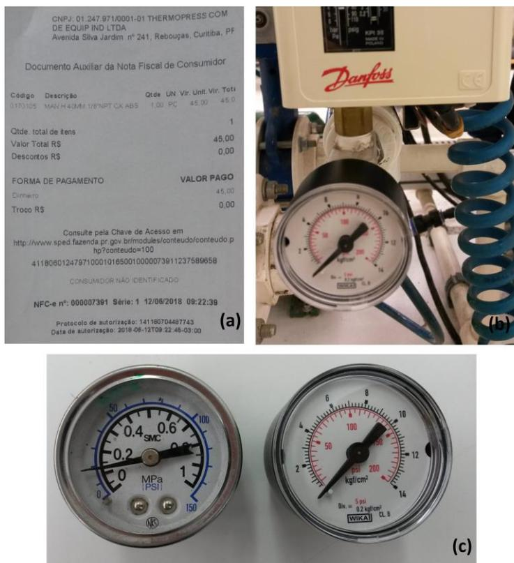
**Figura 39 – Substituição do manômetro danificado. (a) Nota fiscal de compra, (b) novo manômetro instalado, (c) manômetro danificado (à esquerda) e novo equipamento (à direita)**
