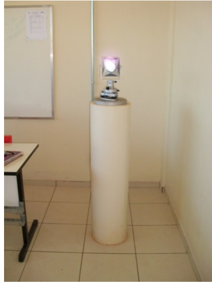
Figura 13 - Ponto 6 e 7: Pilares de centragem forçada. Fonte: A autora (2013).
