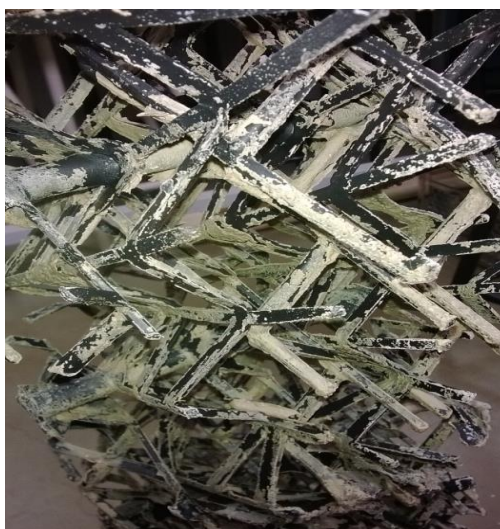
Figura 5.3 - Fotografia da incrustação na grade de enchimento (GE) Fonte: Autoria própria.
