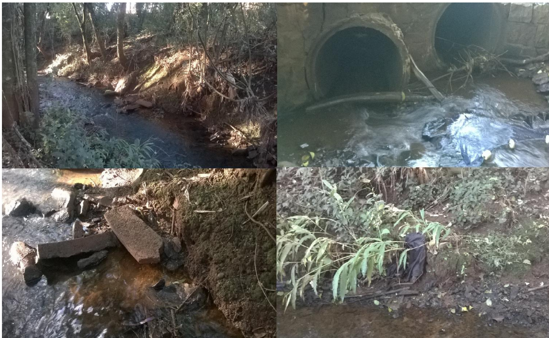
Figura 3 - Riacho urbano, localizado no município de Capitão Leonidas Marques – PR. Fonte: Acervo do autor.
