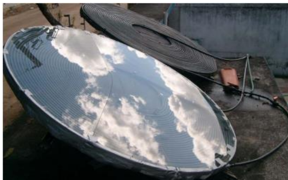
Figura 13 - Aquecedor Solar de forma espiral Fonte: Gonçalves, 2012.
