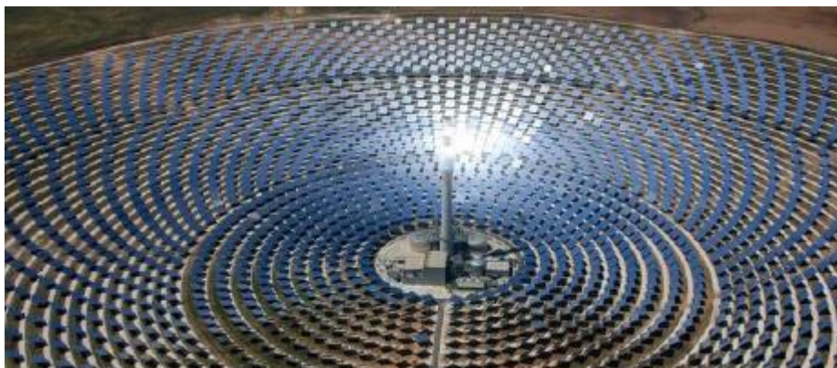
Figura 4 - Concentrador Sistema Torre Solar Fonte: Silva, 2011.
