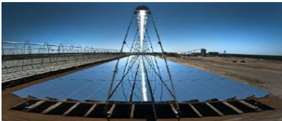
Figura 6 - Concentrador Sistema Linear Fresnel Fonte: Silva, 2011.
