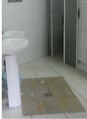
Figura 4- Banheiros utilizados pelos feirantes.
