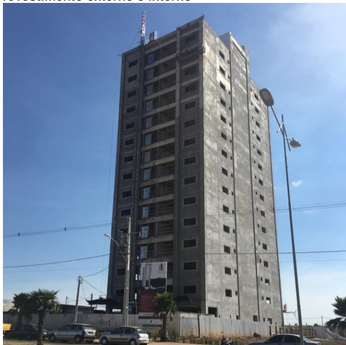
Fotografia 1 – Edifício durante a execução de revestimento externo e interno
