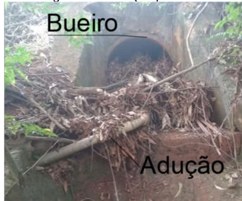
Figura 23: Passagem da tubulação pela rede de drenagem
