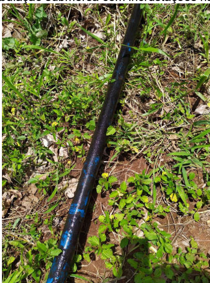
Figura 20: Tubulação submersa com incrustações na parte externa
