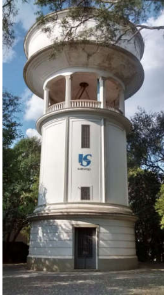
Figura 7: Reservatório do Araçá
