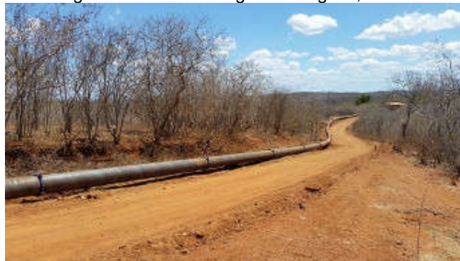
Figura 2: Adutora de água da Cagece, Ceará
