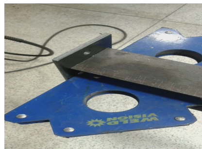
Figura 28 – Soldagem do perfil em I (b) Fonte: Autoria própria
