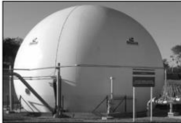
Figura 13 - Gasômetro de dupla membrana GS
