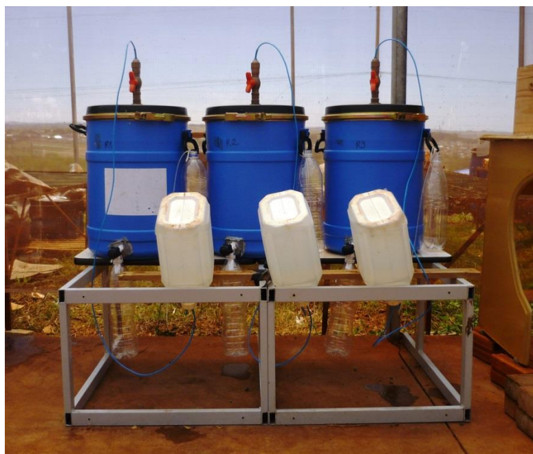
Figura 6 - Reatores instalados na casa de vegetação da universidade
