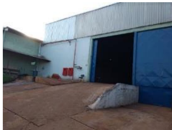
Figura 20. Rampa de acesso – CVMR-LD Fonte: Próprio autor
