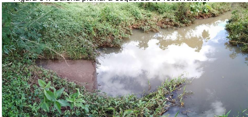
Figura 34: Galeria pluvial a esquerda do reservatório.
