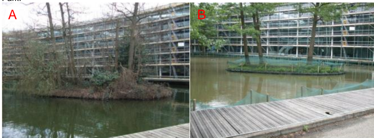
Figura 10: Comparação antes (A) e pós (B) revitalização do parque no estudo de caso: Business Park.
