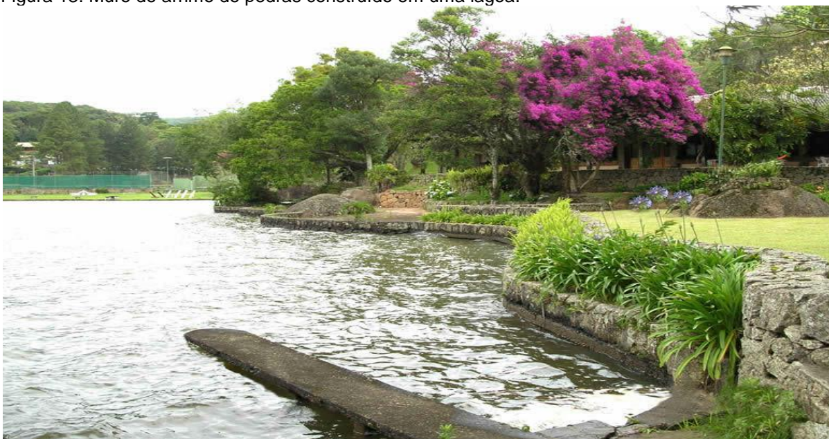
Figura 13: Muro de arrimo de pedras construído em uma lagoa.
