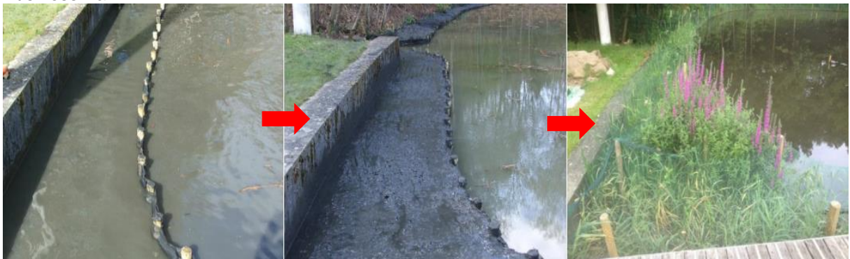
Figura 9: Processo de restauração da margem com a membrana Nicospan no estudo de caso: Business Park.
