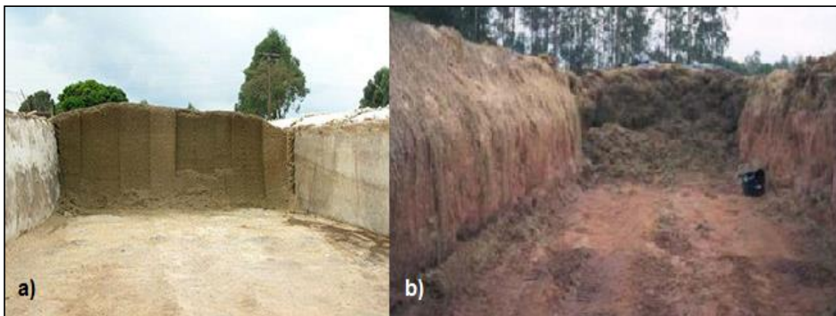
Figura 2 – Silo de alvenaria (a) e armazenamento da silagem direto no solo (b) Fonte: Filho (2011); Mari; Nussio (2004).
