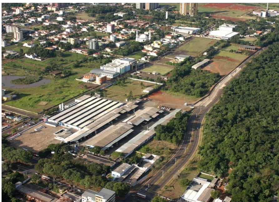
Figura 4 - Vista área da CEASA - Unidade de Foz do Iguaçu Fonte: CEASA (2015).
