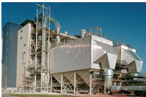
Figura 2 - Precipitador eletrostático industrial Fonte - http://www.cbcsa.com.br/precipitador.asp
