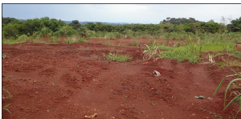
Figura 16 - Vista da trincheira encerrada
