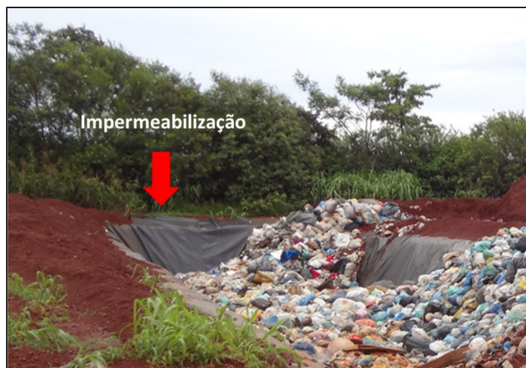
Figura 17 - Sistema de impermeabilização na trincheira
