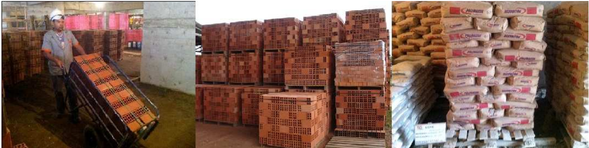
Figura 4 - Exemplo de organização dos materiais em estoque. Fonte: Comunidade da construção (2012).
