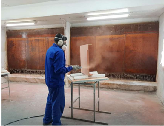
Figura 24- Pintura do acabamento final Fonte: Autoria Própria (2018).
