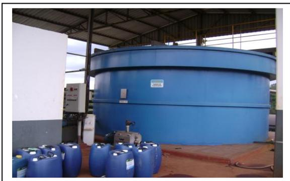
**Figura 13 – Flotador físico-químico**
