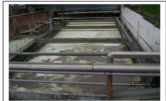
**Figura 7 – Decantador linha vermelha**
