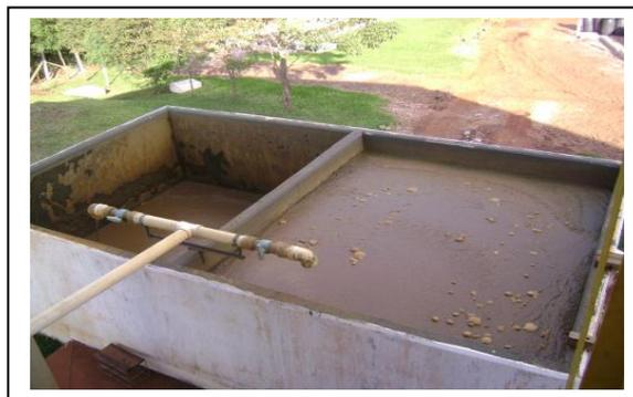
**Figura 14 – Lodo gerado no flotador**
