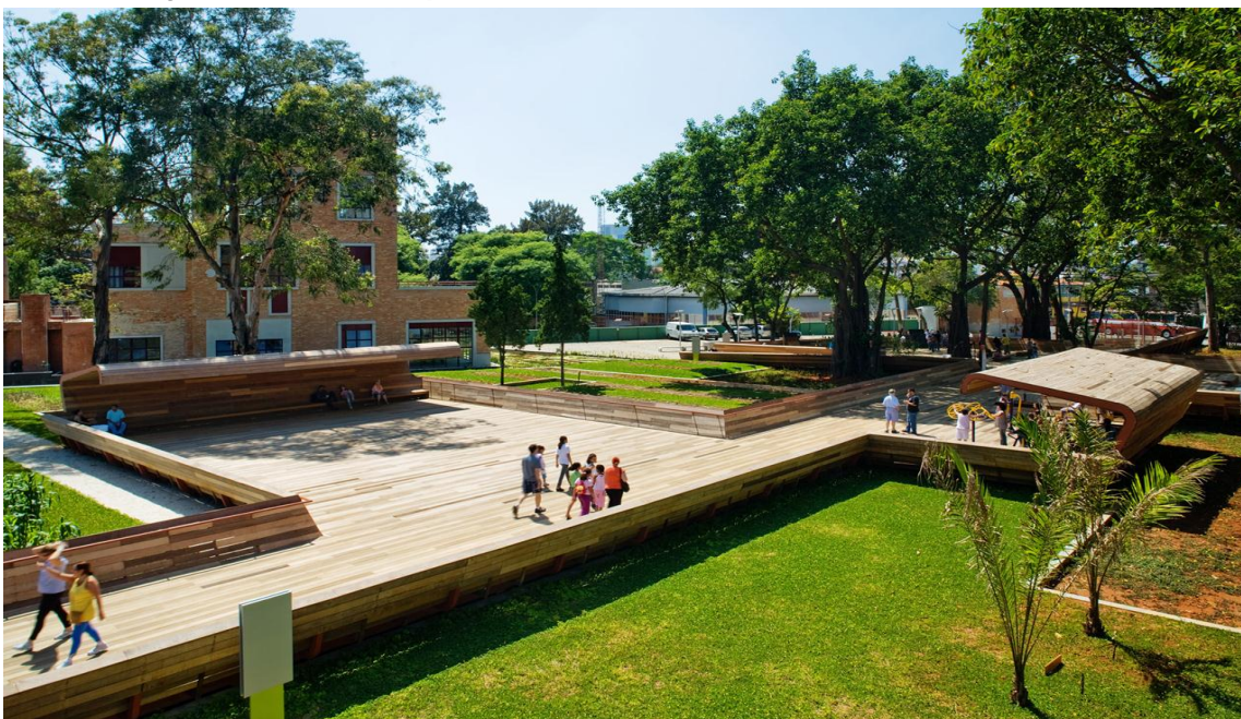
Figura 3: Localizada na Rua Sumidouro, bairro Pinheiros (zona oeste da capital paulista), a praça chama a atenção de quem passa por ali pela quantidade de árvores altas e pelo grande deck de madeira. Feito de ipê, garapa e sucupira, o deck funciona como pista de caminhada e serve como proteção para que os visitantes não entrem em contato com as áreas de solo contaminado.
