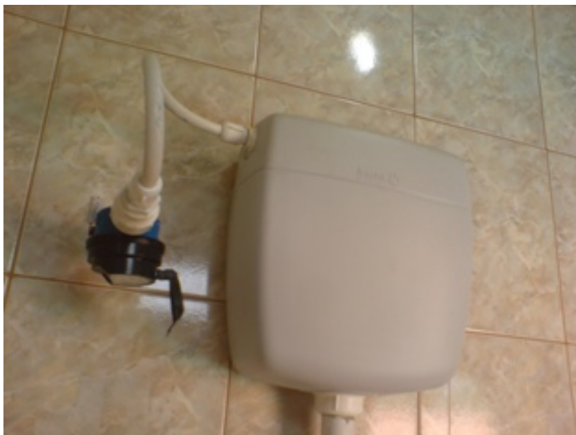
Figura 2: Instalação do hidrômetro no reservatório da descarga
