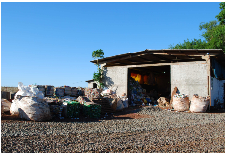
Figura 9: Centro de Triagem Serranópolis do Iguaçu Fonte: Autor
