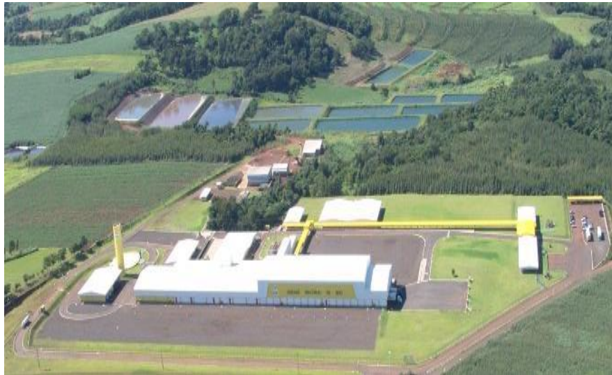
Figura 5: Vista aérea do Frigorífico; Fonte: COPAGRIL (2005).
