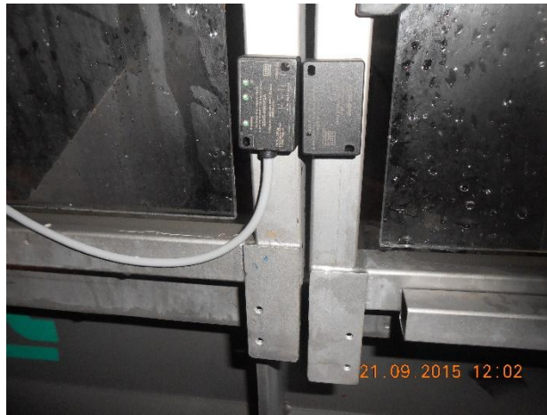
Figura 25: Sensor magnético Hall; Fonte: Autor.
