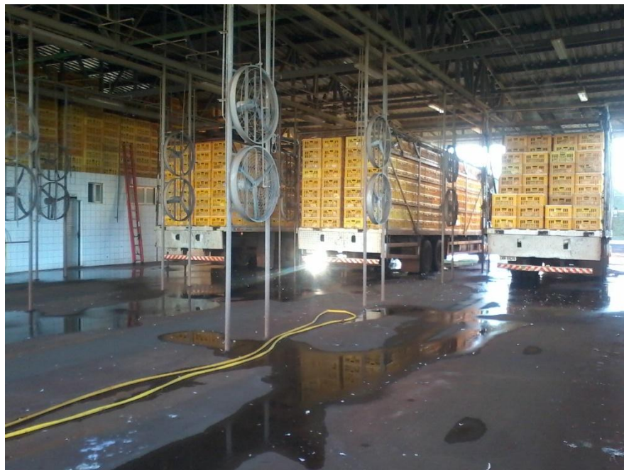
Figura 8: Setor de recepção; Fonte: Autor.
