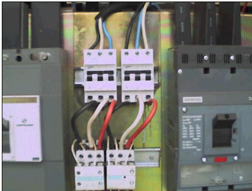
Figura 17 - Disjuntores do banco de capacitores depois da manutenção.
