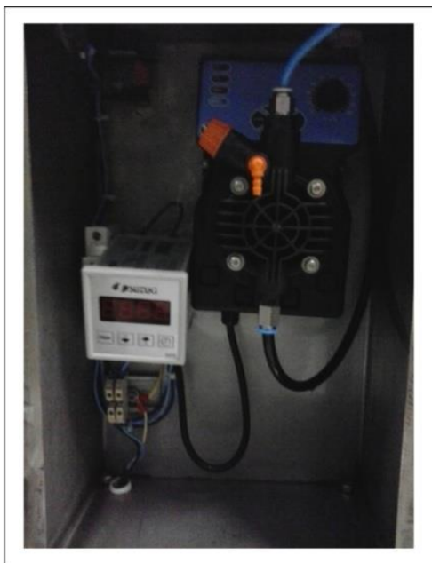
Figura 12 - Comando Modificado com Temporizador Digital Fonte: Autor.
