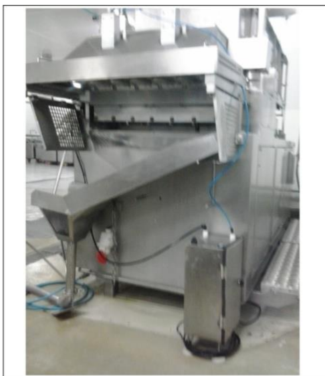
Figura 9 - Sistema de Circulação de Óleo Instalado Fonte: Autor.
