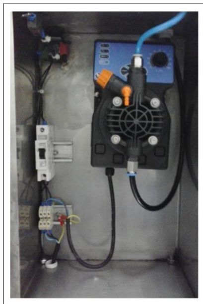
Figura 7 - Vista Interna do Sistema de Circulação de Óleo Fonte: Autor.
