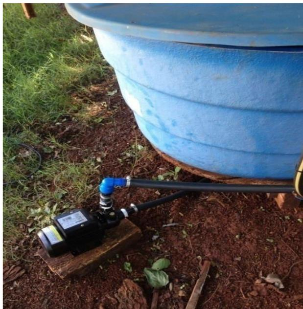
Figura 13–Bomba para a caixa d'água secundária.
