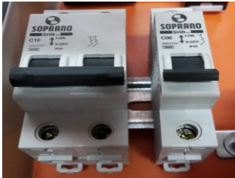
Figura 11 - Disjuntores C10 e C06.
