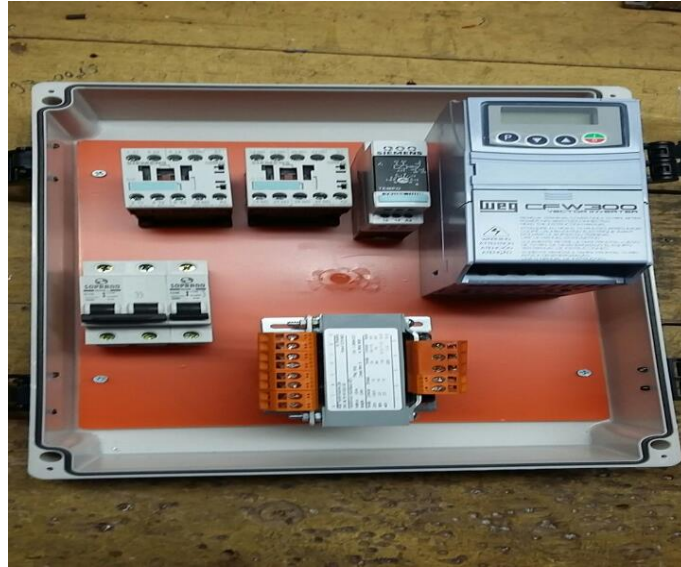
Figura 35 - Verificação do espaço físico da caixa.
