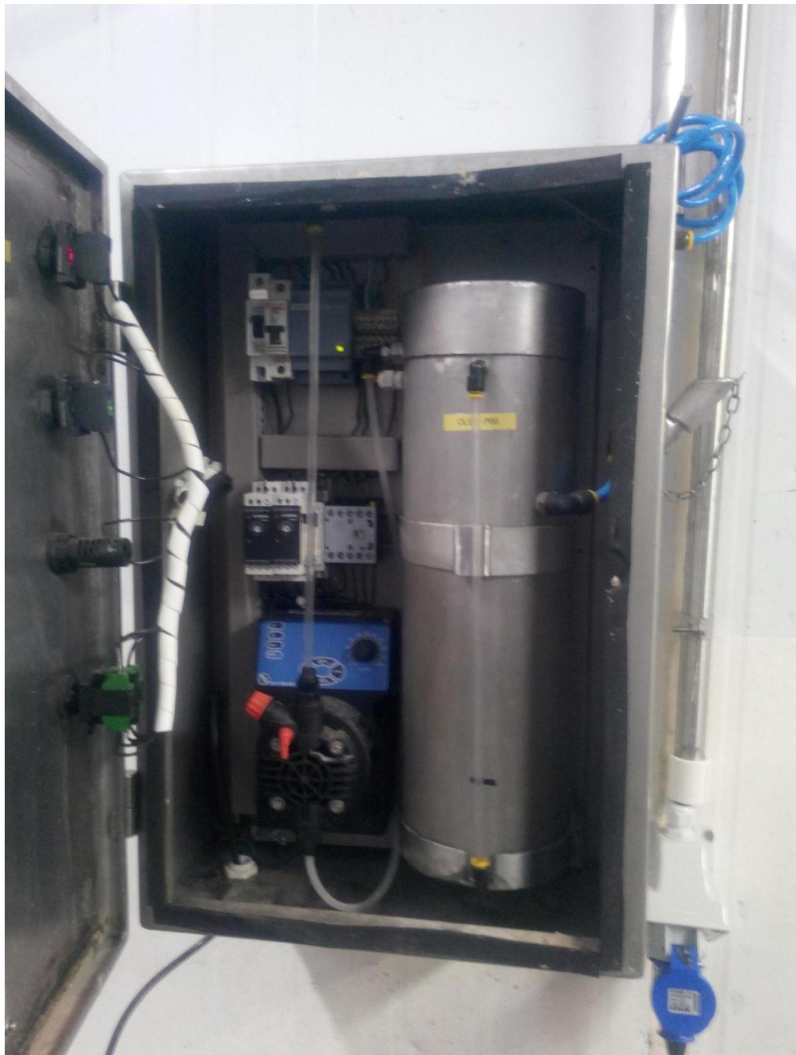
**Figura 3 - Disposição final dos componentes dentro do quadro de comando**
