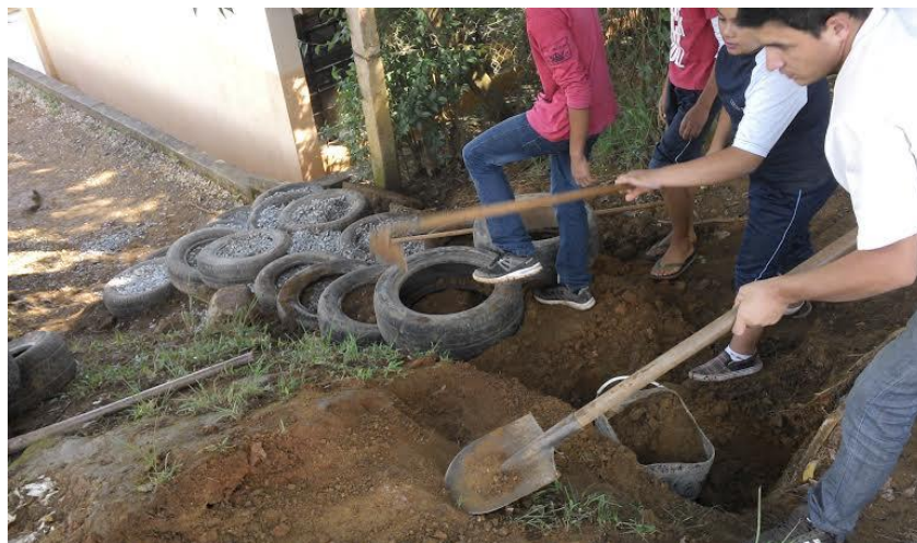
Figura 7: Construção de degraus com pneus para reduzir problemas com erosão. Fonte: Equipe de professores da Escola E7.
