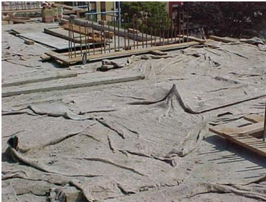
Figura 7 - Cura por recobrimento com manta Fonte: Recena e Pereira (2011, P.572).
