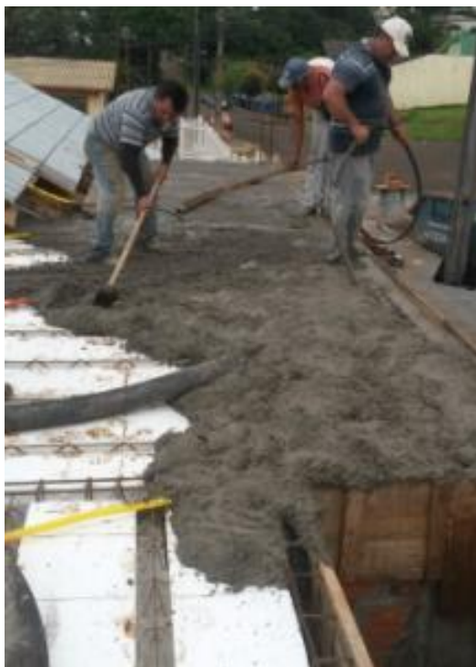
Figura 18-Processo da Concretagem 1 Fonte: As autoras (2016).
