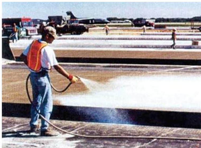
Figura 6 - Cura com película química Fonte: Recena e Pereira (2011, P.572).
