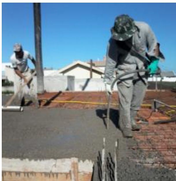
Figura 20- Início da Concretagem 2 Fonte: As autoras (2016).
