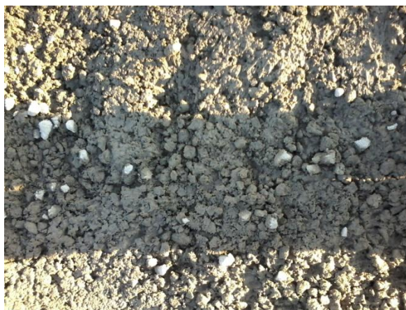
Figura 25- Superfície da laje da Concretagem 3 Fonte: As autoras (2016).
