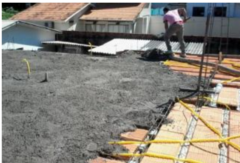
Figura 23- Processo da Concretagem 3 Fonte: As autoras (2016).
