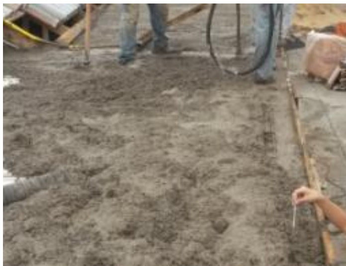
Figura 8 - Aferição da temperatura do concreto na superfície de concreto recém-lançado
