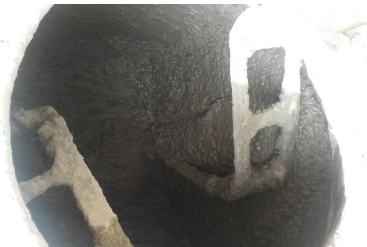
Figura 12- Concreto utilizado para preencher os moldes Fonte: As autoras (2016).
