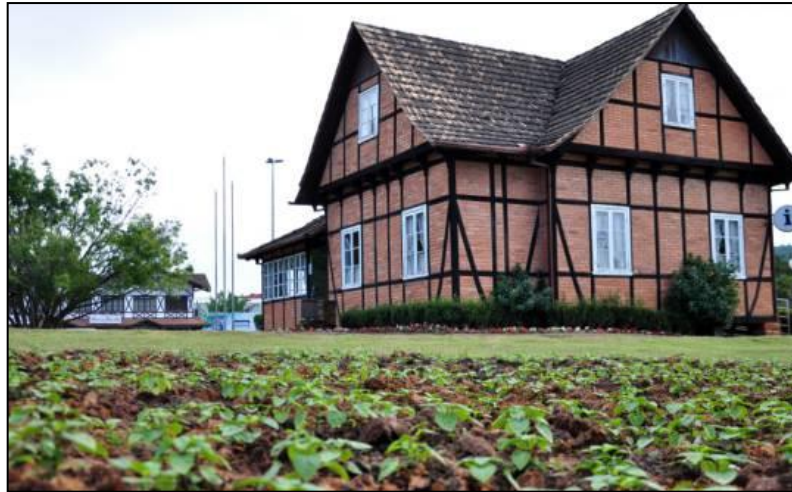
Figura 4 - Casa construída pelo método enxaimel, Blumenau, Santa Catarina Fonte: FRESARD (2016).
