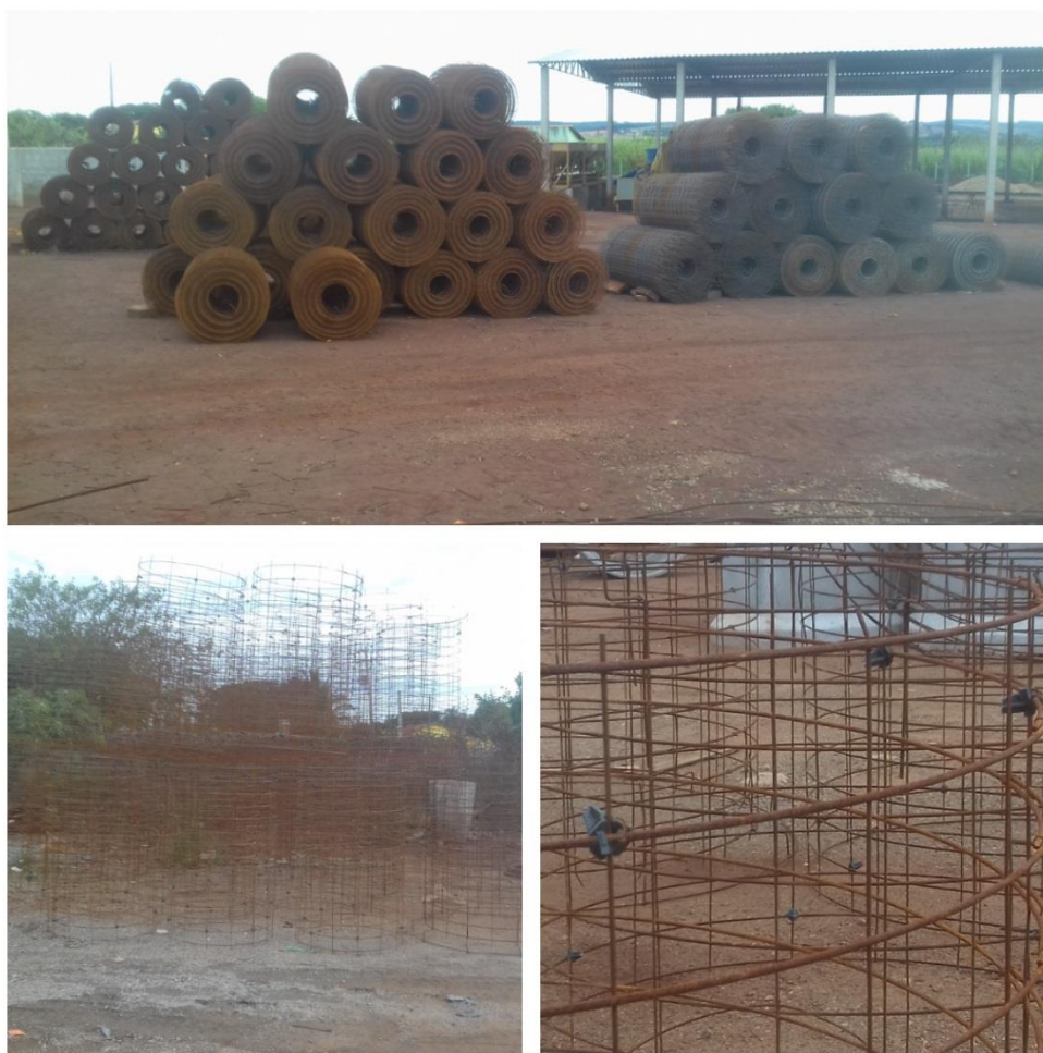
Figura 15 - Armazenamento das armaduras Fonte: Aatoria Própria (2018).
