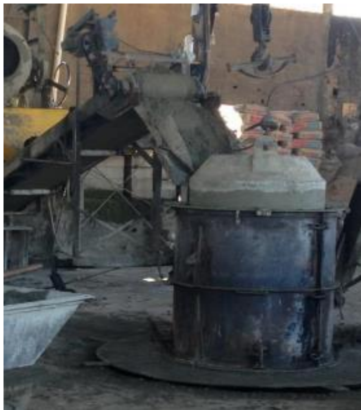
Figura 21 - Lançamento do concreto no conjunto vibratório Fonte: Autoria Própria (2018).
