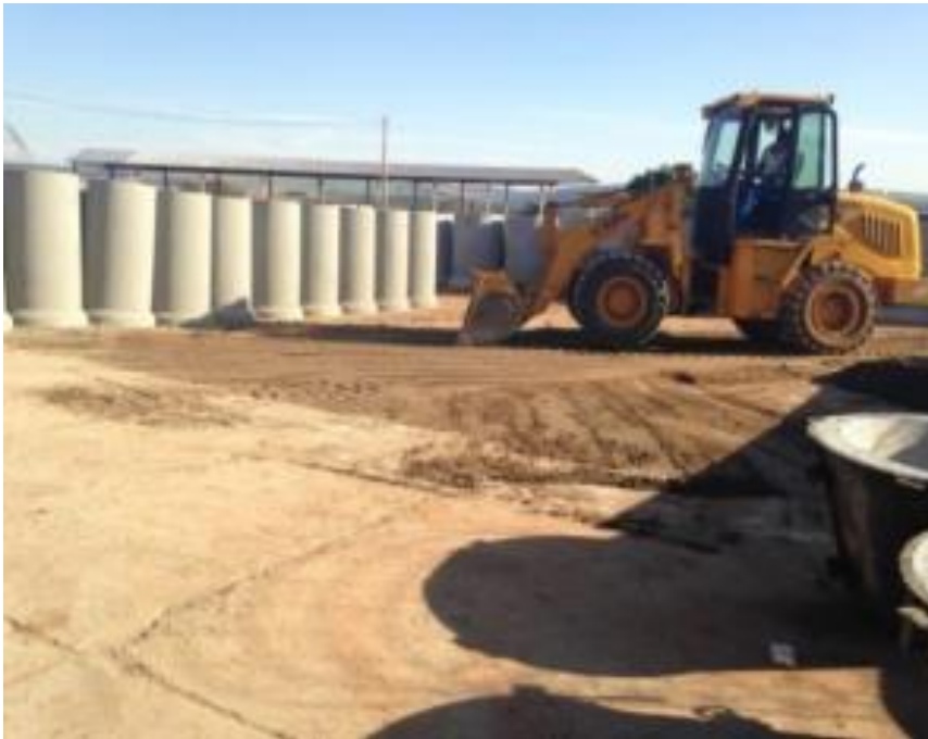
Figura 28 - Nivelamento e limpeza do terreno Fonte: Autoria Própria (2018).
