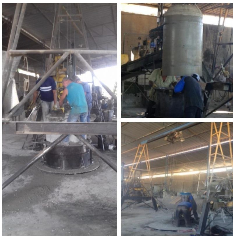
Figura 22 - Içamento da forma interna Fonte: Autoria Própria (2018).
