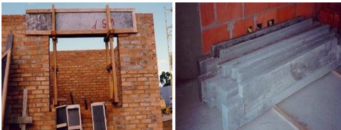
Figura 9: Uso de vergas pré-fabricadas para diminuir etapas na execução da alvenaria Fonte: FORMOSO (2000).
