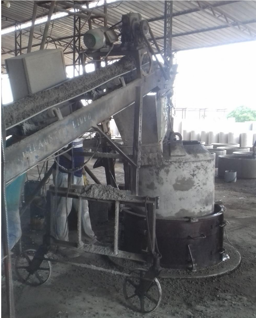
Figura 18 - Esteira rolante conduzindo o concreto para a forma Fonte: Autoria Própria (2018).
