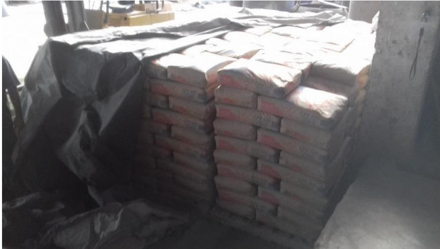
Figura 14 - Estoque de cimento empilhados sobre paletes Fonte: Autoria Própria (2018).
