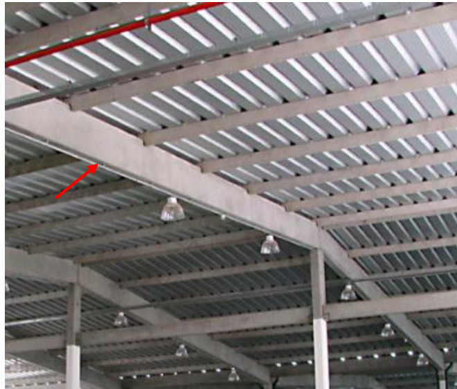
Figura 11: Viga de cobertura inclinada Fonte: Marka Soluções Pré-fabricadas, 2017.
