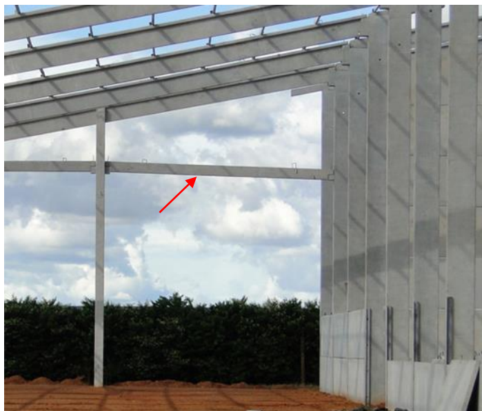
Figura 13: Viga de pórtico Fonte: Cibe Pré-moldados, Concretos e Minerais, 2017.
