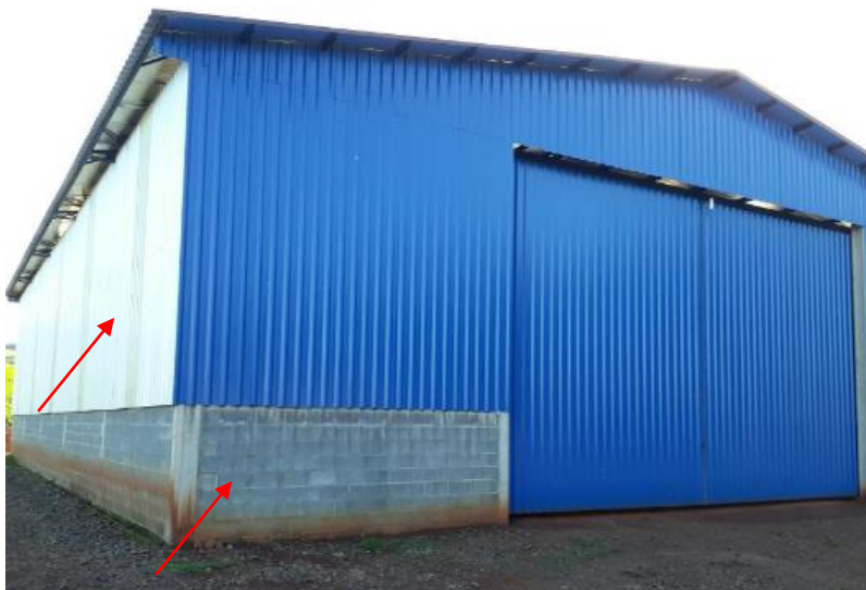
Figura 14: Fechamentos laterais Fonte: Autoria própria, 2017.
