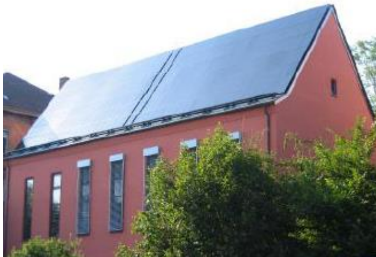
Figura 8 - Exemplo de módulos solares fotovoltaicos de CIGS em substrato de vidro para aplicações arquitetônicas Fonte: Würth Solar GmbH apud RUTHER, 2004.
