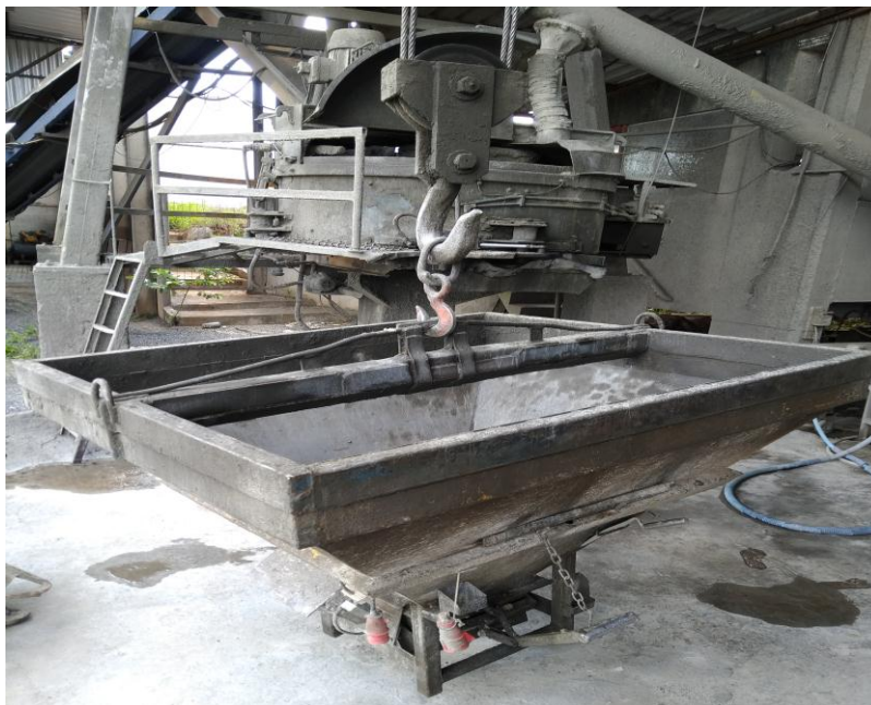
Figura 11: Reservatório para o concreto Fonte: Autoria Própria (2018).
