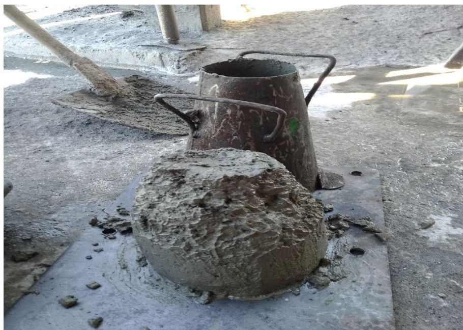
Figura 14: Teste de abatimento do concreto Fonte: Autoria Própria (2018).
