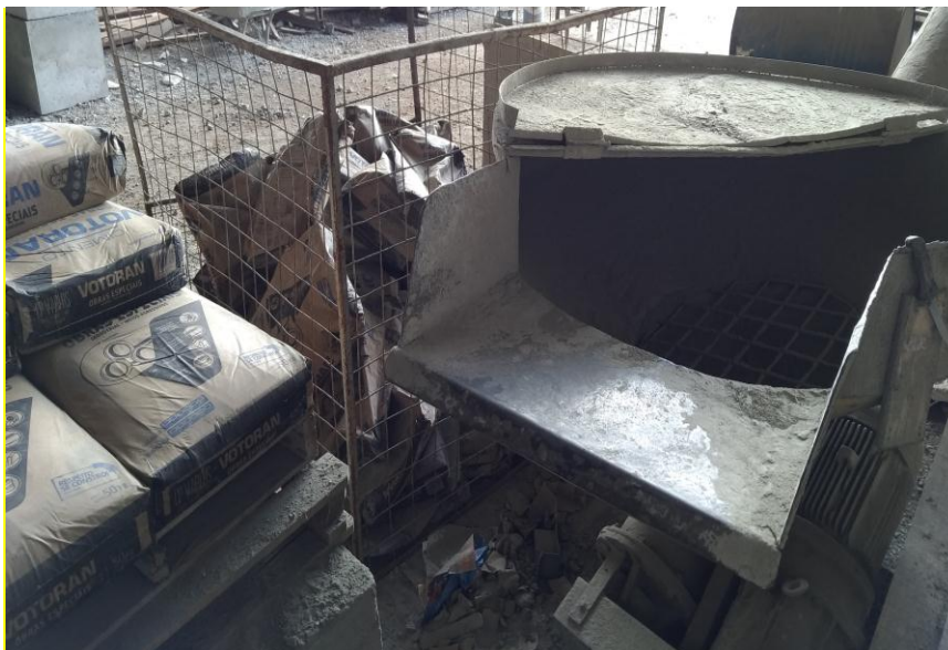
Figura 10: Recipiente para colocação do cimento Fonte: Autoria Própria (2018).
