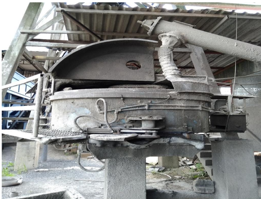
Figura 7: Tambor betoneira Fonte: Autoria Própria (2018).
