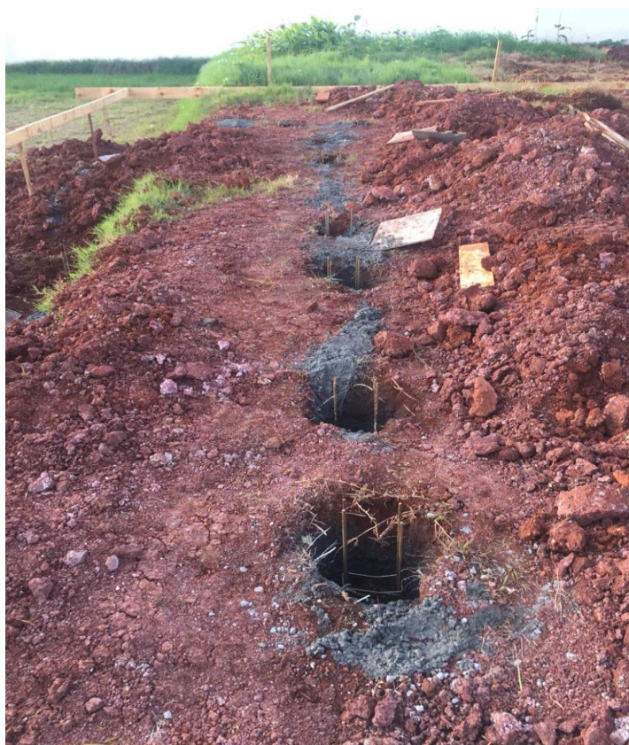
Figura 6 - Concretagem das estacas de fundação
