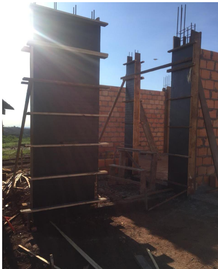
Figura 7 – Fôrmas dos pilares prontas para concretagem
