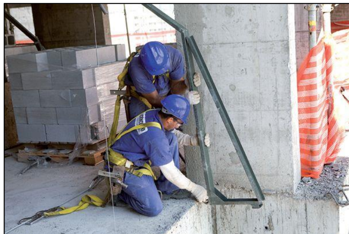
Figura 11 – Linha de vida horizontal temporária Fonte: Segurança – Certo e Errado (2014).
