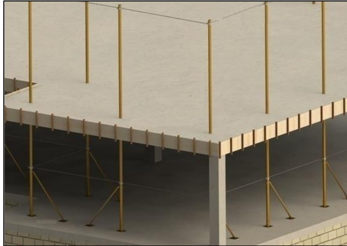
Figura 10 – Linha de vida com abraçadeira e mão-francesa Fonte: Essencial Equipamentos, 200-.
