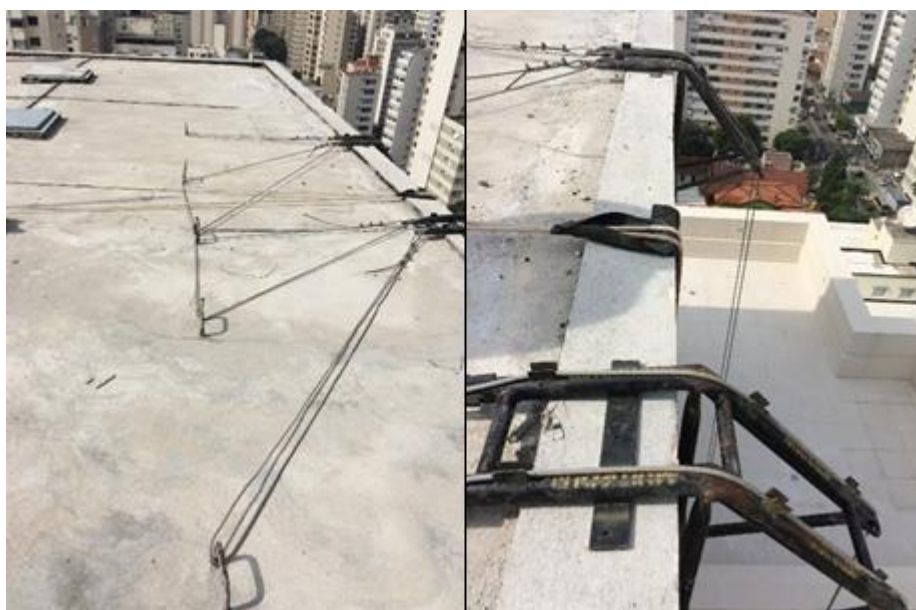
Figura 6 – Andaime suspenso: sistema com afastador em ancoragem Fonte: Adaptado de Carvalho, 2015.
