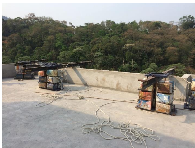
Figura 8 – Sistema de contrapeso Fonte: Carvalho, 2015.
