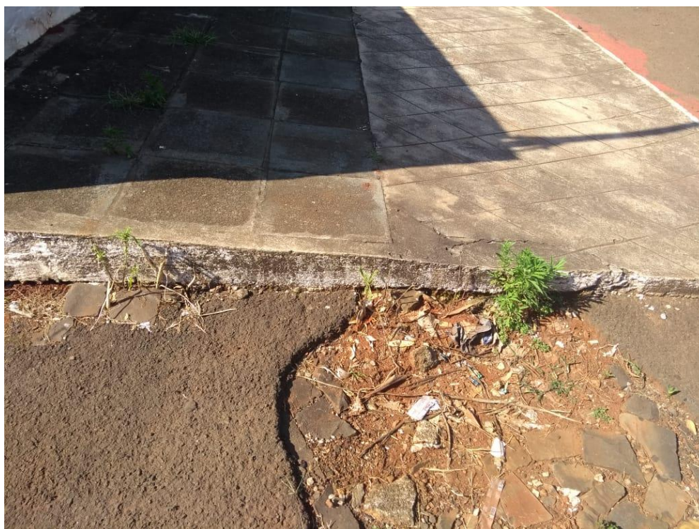
Figura 16- Degraus Fonte: Autoria própria (2018)
