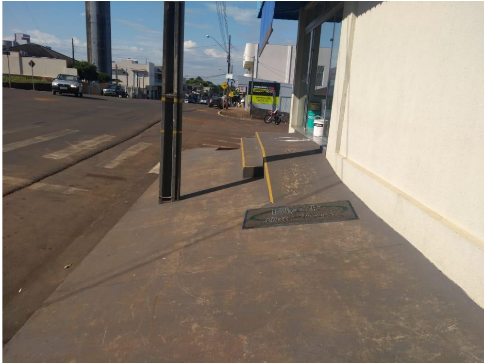
Figura 17- Acesso a estabelecimentos comerciais Fonte: Autoria própria (2018)
