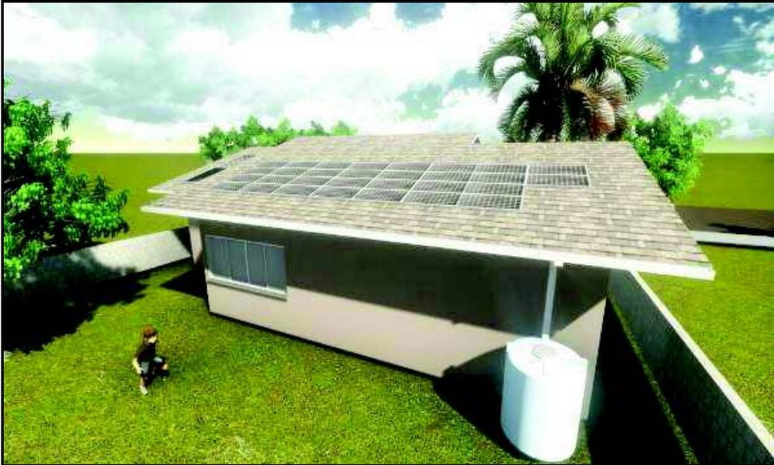
**Figura 38: Captação da água chuva**
