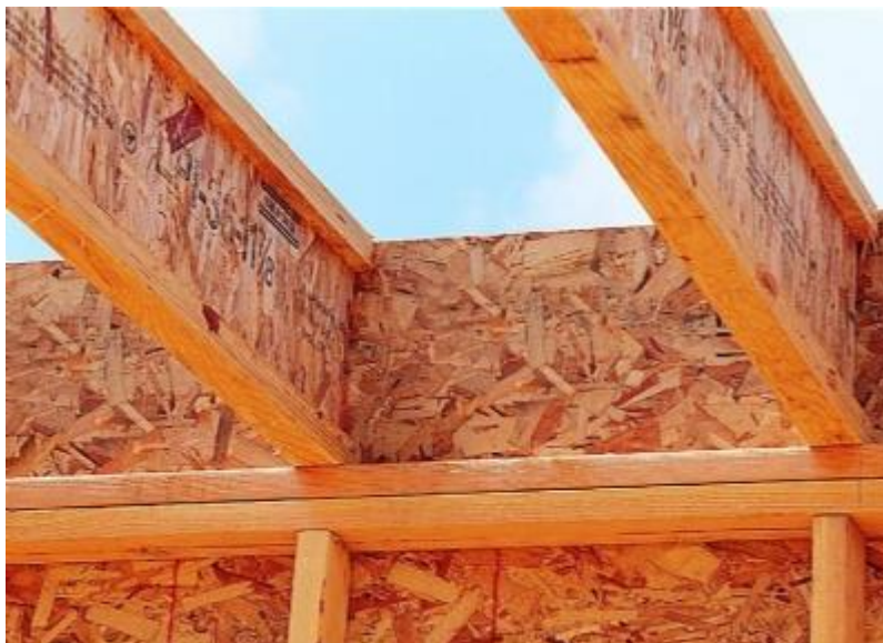
Figura 3 - Vigas I (alma de OSB e mesas de madeira maciça – Pinus). Fonte: LP do Brasil (2013)
