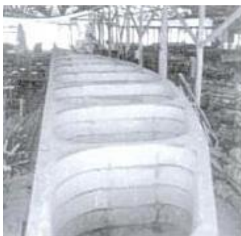
Figura 9 - Tesouras em forma de viga Vierendeel Fonte: Vasconcelos, 2002.
