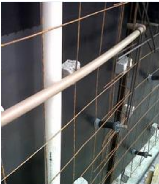
Figura 35 - Detalhe da instalação hidrossanitária já alocada na forma Fonte: Casas e projetos, 2015.
