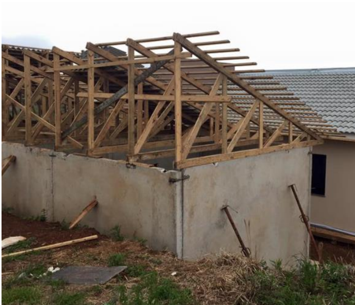
Figura 77 – Estrutura de cobertura sobre as placas Fonte: Modular, 2015.
