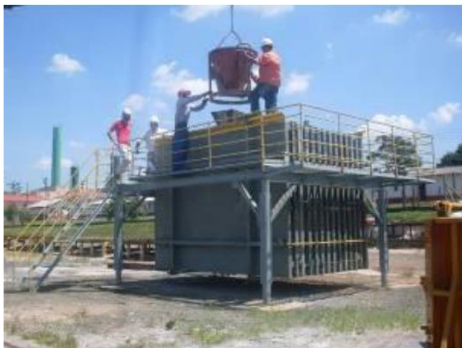
Figura 66 – Concretagem de bateria de fôrmas na vertical Fonte: DATec 07, 2014.
