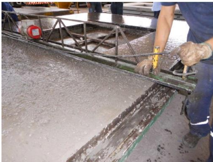
Figura 67 – Regularização com uso de régua vibratória Fonte: DATec 29, 2016.
