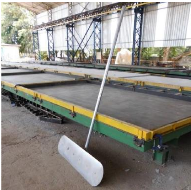
Figura 69 – Regularização com uso de desempenadeira metálica Fonte: DATec 29, 2016.
