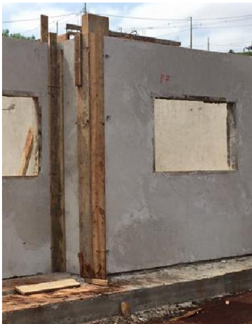
Figura 74 – Tábuas de madeira usadas no grauteamento Fonte: Modular, 2015.
