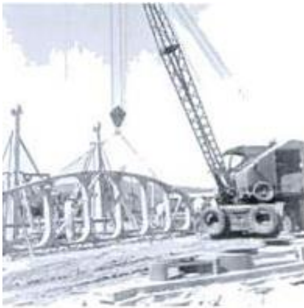
Figura 10 - Tesouras sendo içadas por grua sobre pneus Fonte: Vasconcelos, 2002.
