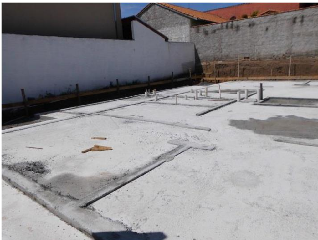
Figura 60 – Fundação do Tipo Radier Fonte: DATec 29, 2016.
