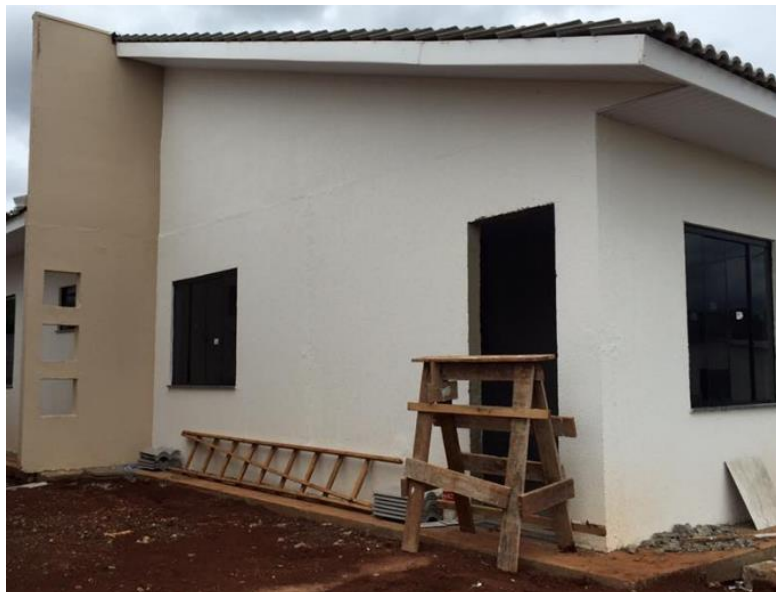
Figura 78 - Pintura com Textura feita sobre Placa de Concreto Pré-fabricada Fonte: Modular, 2015.
