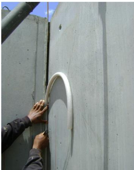
Figura 75 – Colocação da Junta Fonte: DATec 07, 2014.
