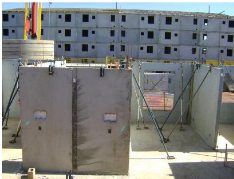
Figura 72 – Escoramento dos Painéis Fonte: DATec 07, 2014.
