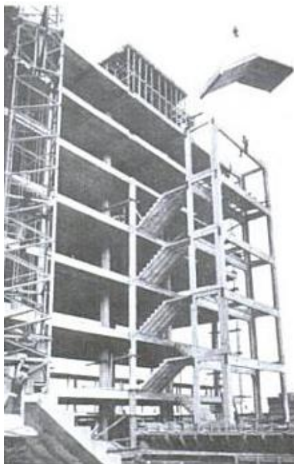
Figura 13 - Execução de um dos prédios do conjunto CRUSP, São Paulo Fonte: Vasconcelos, 2002.
