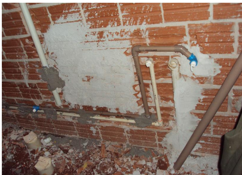
Figura 34 - Instalações hidrossanitárias convencionais Fonte: Arte decoração, 2012.
