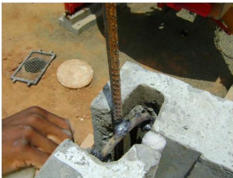
Figura 73 – Soldagem das Barras Fonte: DATec 07, 2015.
