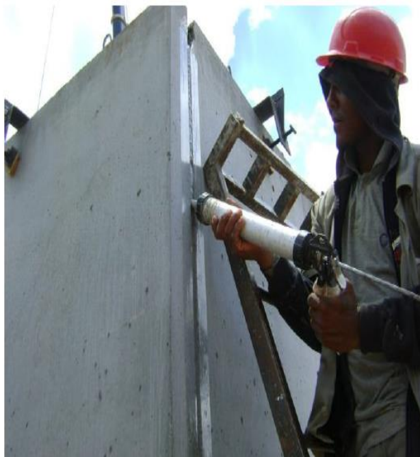
Figura 76 – Aplicação do Selante Fonte: DATec 07, 2014.
