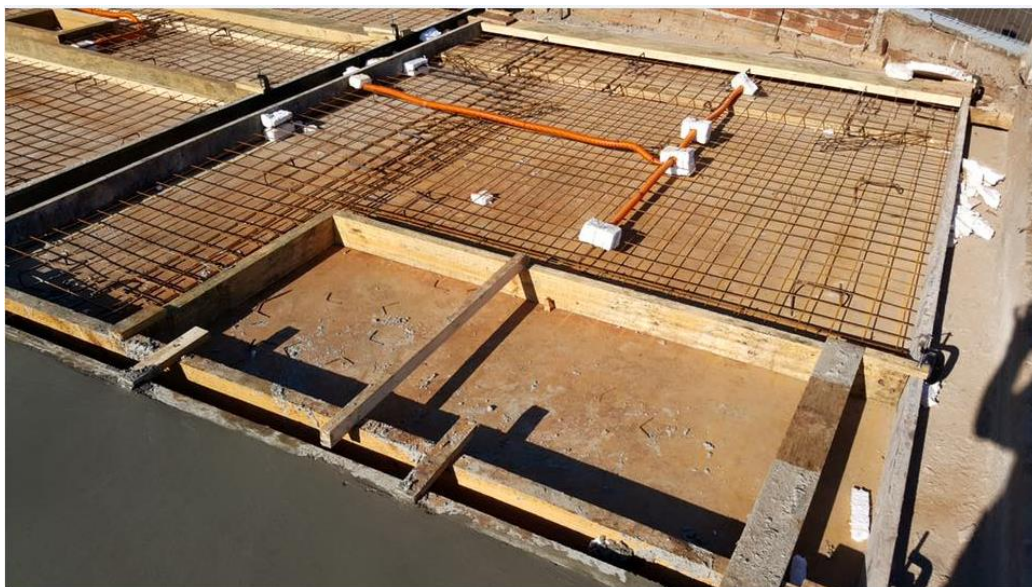
Figura 63 – Fôrma de Madeira Fonte: Modular, 2015.
