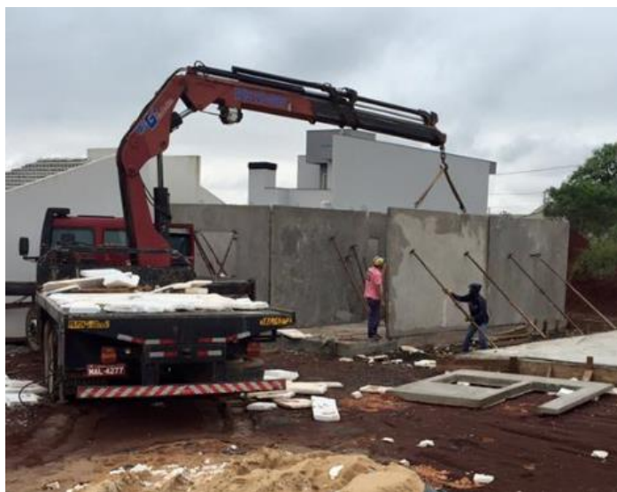
Figura 70 – Transporte e posicionamento da placa com auxílio de caminhão munck Fonte: Modular, 2015.
