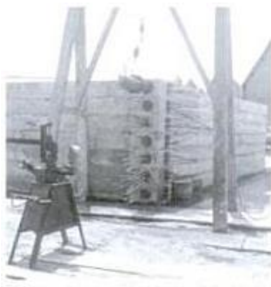
Figura 8 - Peças empilhadas no canteiro de obras Fonte: Vasconcelos, 2002.
