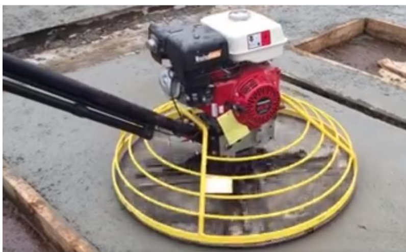
Figura 68 – Regularização com uso de “disco de polimento” Fonte: Modular, 2015.
